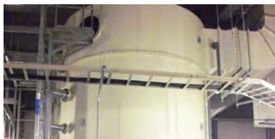
スクラバー（排ガス洗浄装置） 安定処理のための構造・仕様
