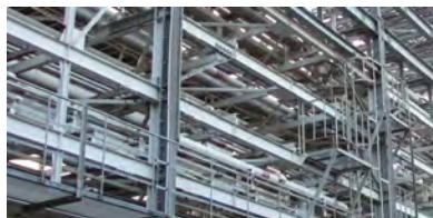
架空配管 土壌汚染のリスク低減（埋設配管なし）
