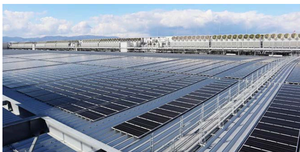
キオクシア岩手株式会社の太陽光発電システム（第1製造棟）
