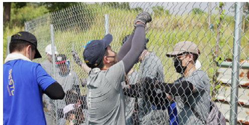
金網を設置する様子
