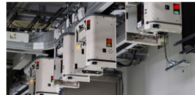
クリーンルーム内搬送装置
