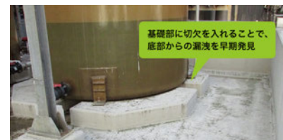
六面点検 六面点検による異常の早期発見
