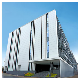
新子安テクノロジーフロント
