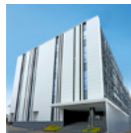
新子安テクノロジーフロント
