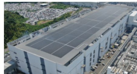
四日市工場第5製造棟の太陽光発電システム
