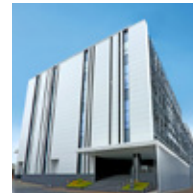
新子安テクノロジーフロント
