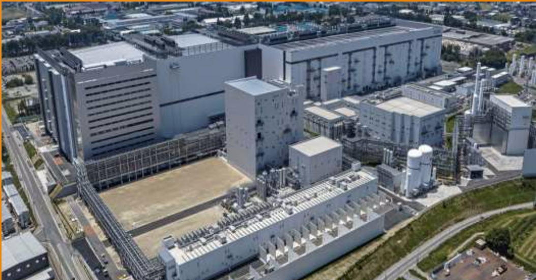
北上工場 2つの製造棟
